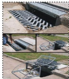
BOCAS DE TORMENTA CON RETENCIÓN DE SÓLIDOS.
